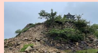
整備が遅れて石垣が崩落
