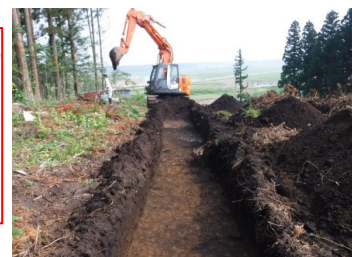
現地での試掘・確認調査
