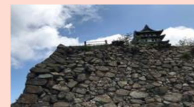
孕み出しが進み崩落の危険があった石垣
