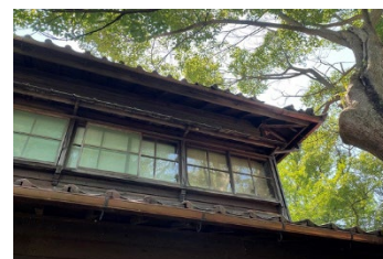
(1) 地域のシンボルとなっている 国登録文化財の修理
