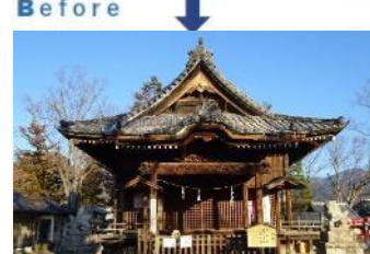
祝神社拝殿（長野県） 屋根を葺き替え、外観を維持
