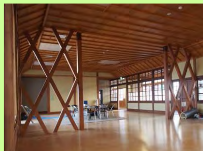
耐震対策装置の設置
