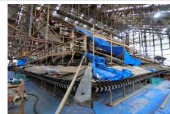
重要文化財 本隆寺本堂ほか2棟 半解体修理の様子(京都府)
