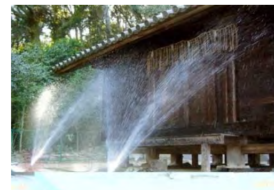
《消火施設(放水銃)の設置》
