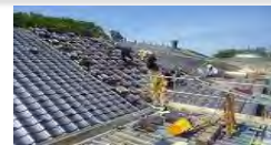
(建造物の修理)
