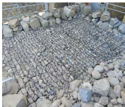
石垣内部栗石の網目状シート補強
