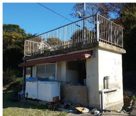
写-32 屋上がフラットルーフの
