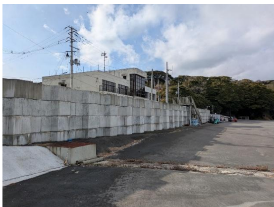
03 防潮堤(海側からみる)
