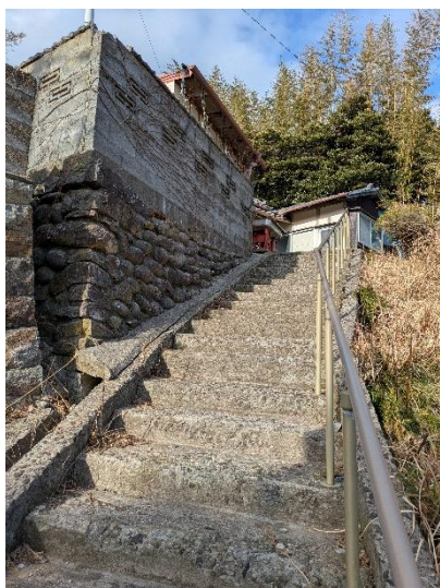
29 路地のコンクリート製階段
