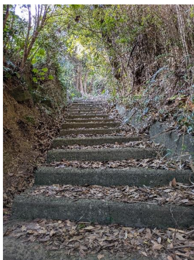
30 路地のコンクリート製階段
