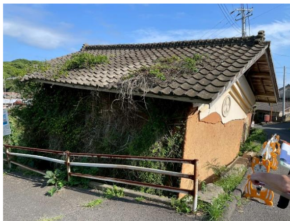
写-33 土蔵(明治期の建設)
