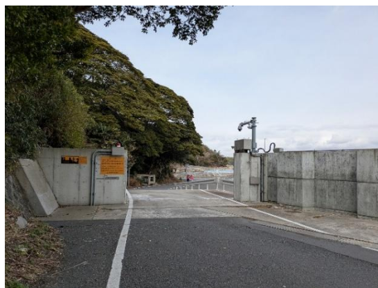
04 防潮堤と水門(内陸側から)
