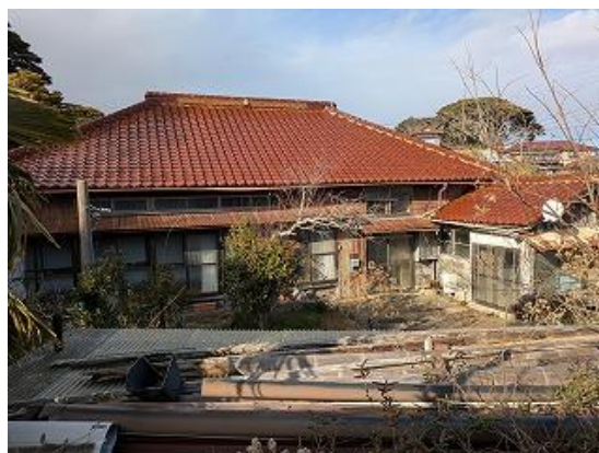
写-24 明治の大火後の再建主屋 和小屋構造
