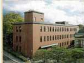
京都国立博物館修理所 昭和54年竣工、築41年
