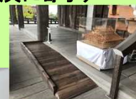
勝興寺本堂 バリアフリー整備 スロープの設置 （富山県）
