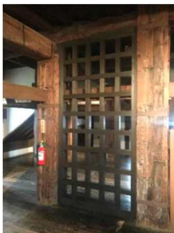
「天守閣の木製格子壁による補強」
