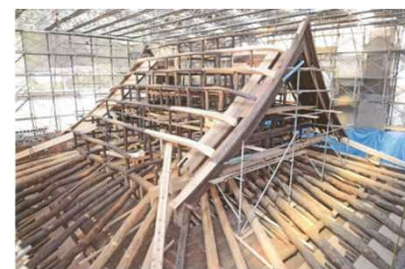
重要文化財 常称寺本堂ほか2棟 解体修理の様子（広島県）
