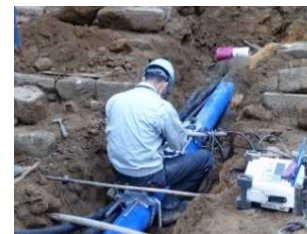
「耐久性、耐震性の高いポリエチレン管への更新」
