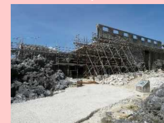
史跡「北大東島横釜山遺跡」の石積修理（沖縄県北大東村）
