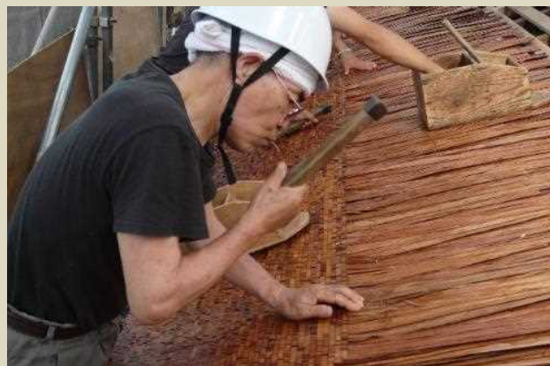
檜皮葺施工の様子
