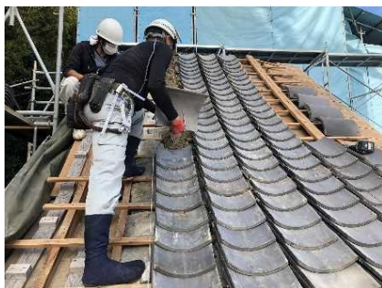
【屋根瓦葺（本瓦葺）】瓦葺き実習
