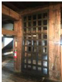
「天守閣の木製格子壁による補強」
