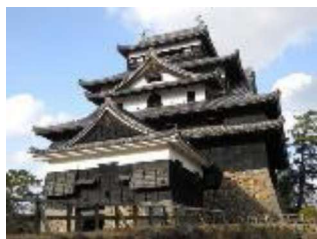
「天守閣の木製格子壁による補強」
