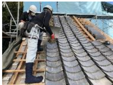
【屋根瓦葺（本瓦葺）】瓦葺き実習
