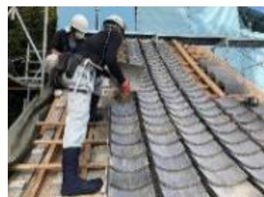
【屋根瓦葺（本瓦葺）】瓦葺き実習
