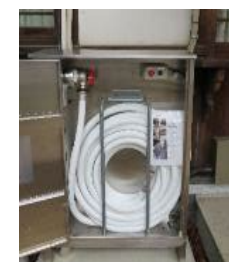
(易操作性1号消火栓) 初期消火、火災の拡大を防ぐための 消火栓設備 等
