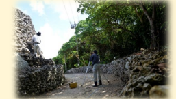
史跡「先島諸島火番盛」の石垣測量 (沖縄県宮古島市・石垣市・多良間村・竹富町・与那国町)
