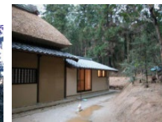
保存管理施設の設置
