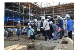
修理現場公開の様子 願興寺本堂（岐阜県）
