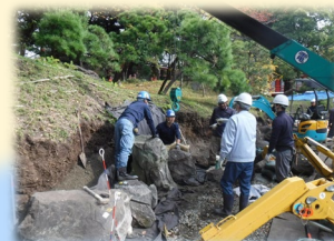
名勝「伝法院庭園」の庭園修景整備 (東京都台東区浅草寺)
