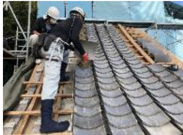
【屋根瓦葺（本瓦葺）】瓦葺き実習
