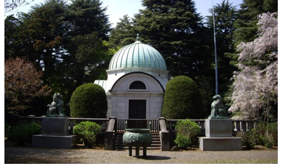
岩崎家玉川霊廟 (J. コンドル設計) 明治43年(1910)築
