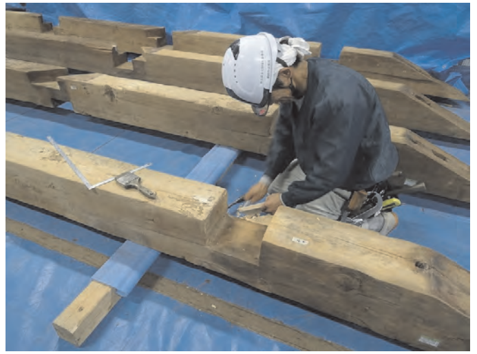
県文化財保存事務所による建造物修理
