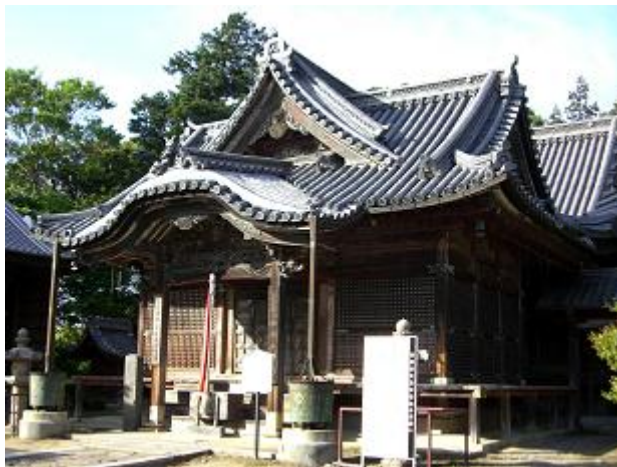
長寿院弁才天堂（重要文化財）
