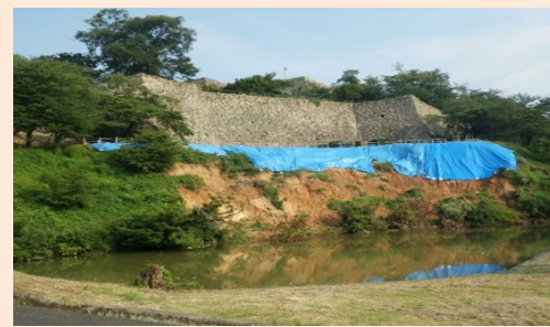
被災事例（史跡津山城跡） 城郭公園内の遊歩道下の法面が崩落。
