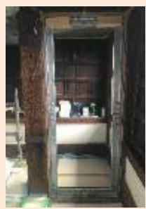
耐震対策工事（松江城天守） 左：格子壁補強 右：鉄骨フレーム
