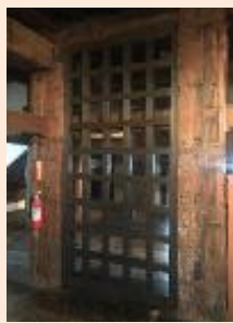
耐震対策工事（松江城天守） 左：格子壁補強 右：鉄骨フレーム
