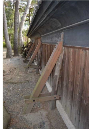
(参考) 指定外の塀への控柱追加及び基礎補強
