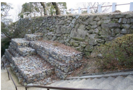
(参考) 石垣前面に石材を詰めたカゴを配置し、倒壊を抑止
