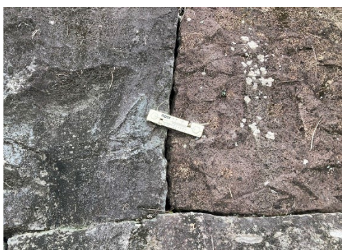
(参考) クラックゲージによるモニタリング
