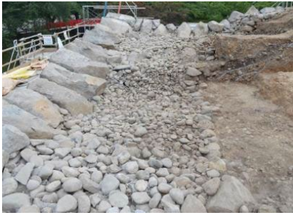
(参考) 表面の石材（築石）と裏込めのぐり層、古い地層（背面盛土）で構成された石垣
