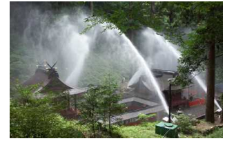
◀消火施設(放水銃)の設置▶
