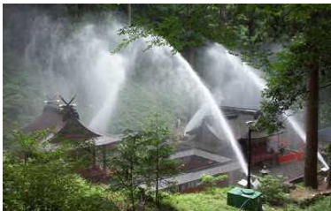
《消火施設(放水銃)の設置》
