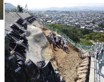
災害復旧工事の状況 (斜面保護のアンカー施工) 史跡「丸亀城跡」 (香川県丸亀市)
