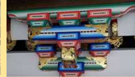
(建造物の美観向上 (塗装の振り直し)
