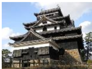
「天守閣の木製格子壁による補強」
