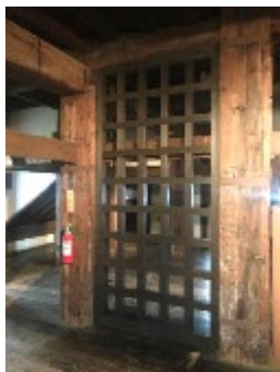
「天守閣の木製格子壁による補強」
