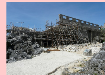
史跡「北大東島燐鉱山遺跡」の石積修理（沖縄県北大東村）
