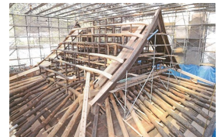
重要文化財 常称寺本堂ほか2棟 解体修理の様子(広島県)
