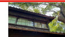
(建造物の修理)
