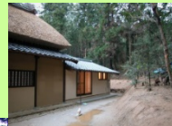
保存管理施設の設置
