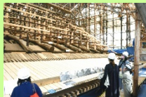
修理現場公開の様子 本隆寺本堂(京都府)
