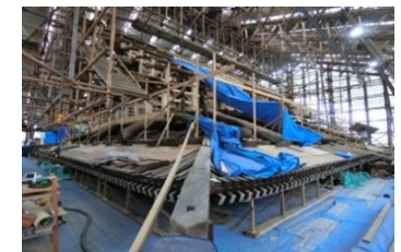
＜建造物半解体修理の様子＞ 重要文化財 本隆寺本堂 (京都府京都市)
