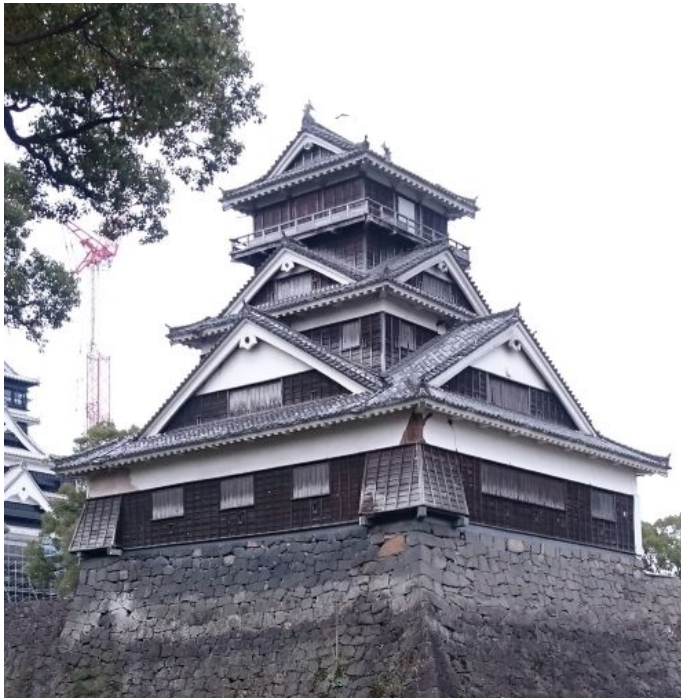
●有形文化財（建造物）
