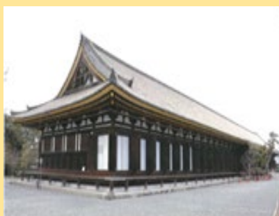
(建造物の美観向上 (塗装の振り直し)
