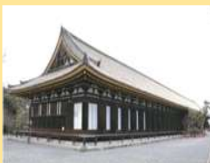
(建造物の美観向上 (塗装の振り直し)
