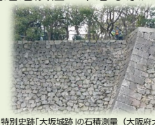
特別史跡「大坂城跡」の石垣測量 (大阪府大阪市)
