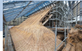
<建造物解体修理の様子> 重要文化財 天徳寺本堂ほか2棟 (秋田県)
