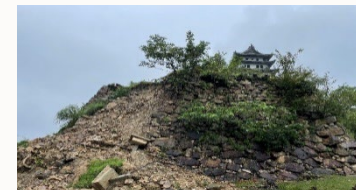
整備が遅れて石垣が崩落
