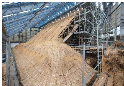
重要文化財 天徳寺本堂ほか2棟 半解体修理の様子（秋田県）
