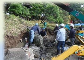
名勝「伝法院庭園」の庭園修景整備 (東京都台東区浅草寺)
