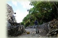
史跡「先島諸島火番盛」の石垣測量 (沖縄県宮古島市・石垣市・多良間村・竹富町・与那国町)
