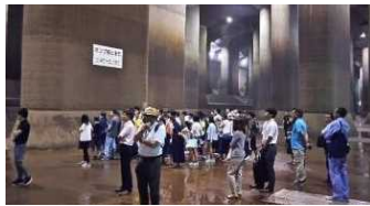
首都圏外郭放水路
