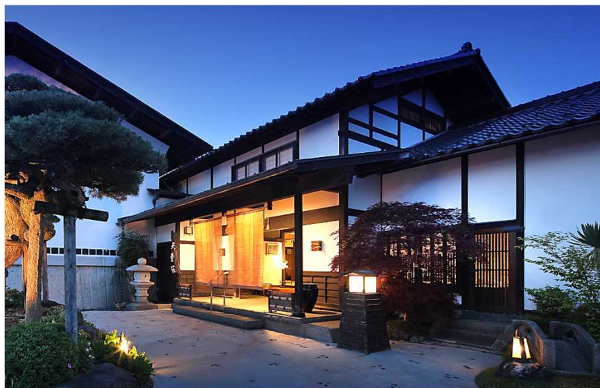
観光地の面的再生に資する宿泊施設の大規模改修支援の例 (山形県銀山温泉「天童温泉」)
