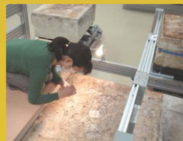
修理作業の様子
