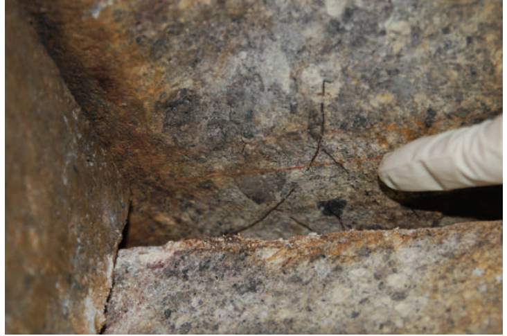
天井石 1 の朱線(下から見上げる・右が西)
