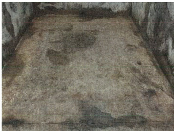
床面の棺台痕跡（南から）
