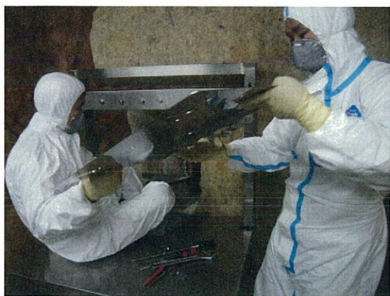
石室進入装置の取外作業
