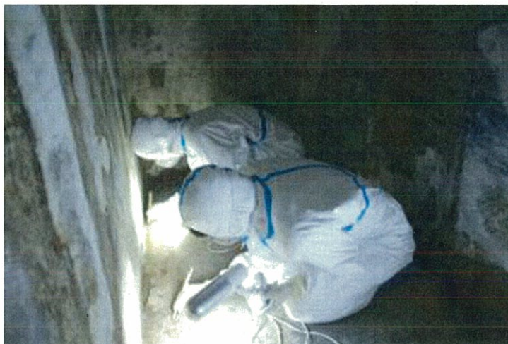
作業風景（床面の精査）
