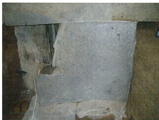
拓本作業 (南壁石南面部分)
