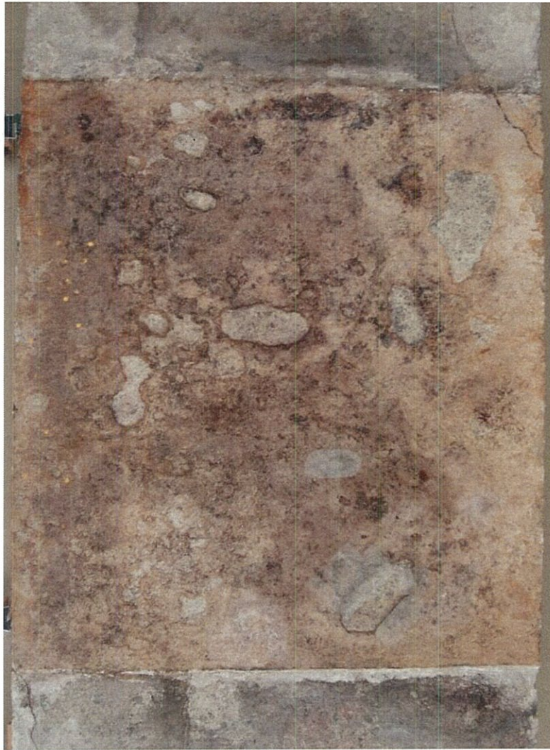
壁画取り出し後 (平成19年)
