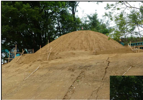
墳丘の盛土造成中
