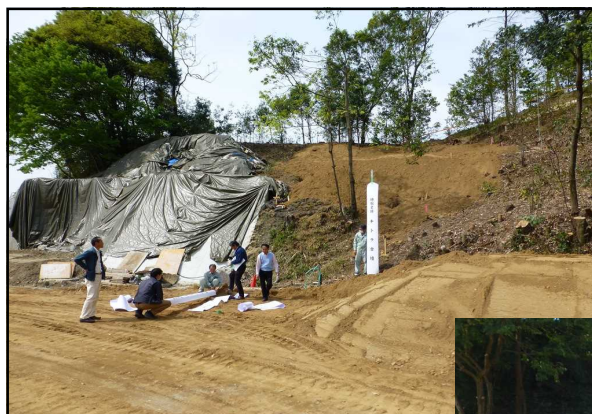
保存施設の大半を撤去した状況
