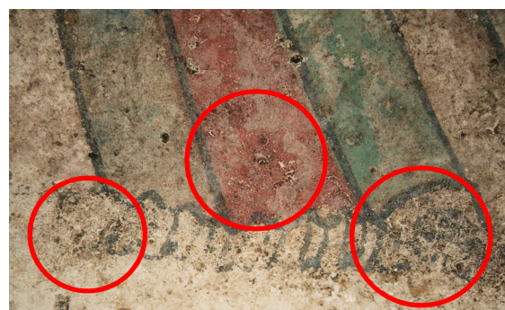
図 2 西女子裾部分 膠施工後
