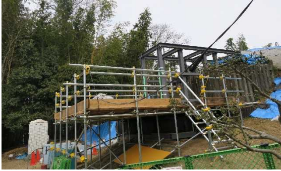
覆屋枠組・足場設置状況
