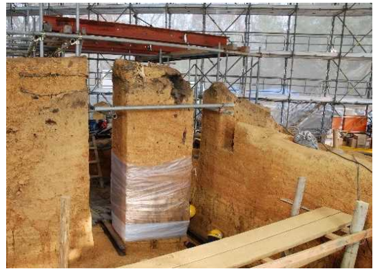
上段調査区版築柱状切り取り (幅1.3×厚1.1×高3.0m)
