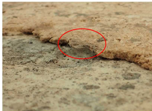
漆喰の粗鬆化により辺縁部の支持が失われた例（天井3）（左）および充填箇所（右）
