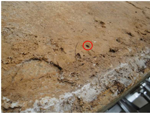
漆喰の粗鬆化により陥没した例（北壁）（左）および充填箇所（右）
