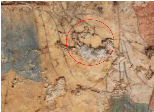
粗鬆化した漆喰により最表層が動いた例 (西壁女子群像) (左:平成 25 年、右:平成 30 年)
