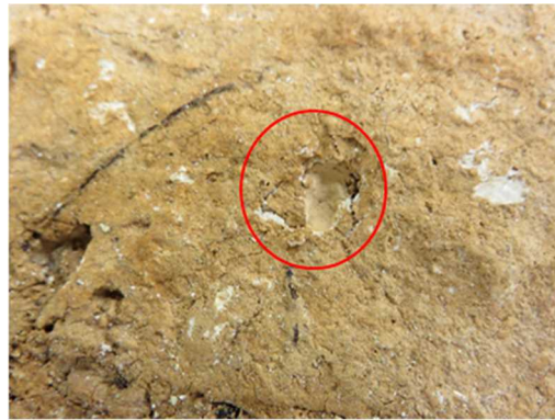
漆喰の粗鬆化により陥没した例（北壁）（左）および充填箇所（右）
