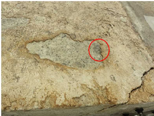
漆喰の粗鬆化により辺縁部の支持が失われた例（天井3）（左）および充填箇所（右）
