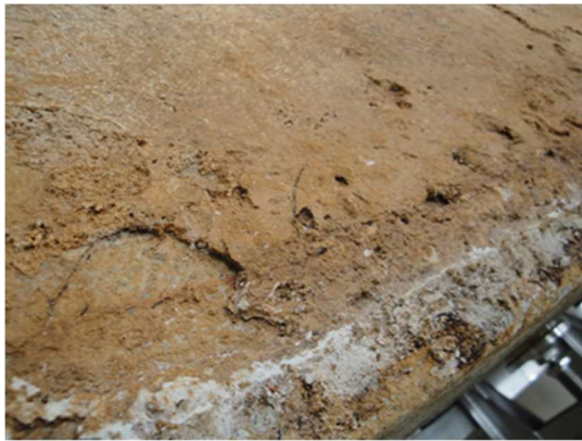
粗鬆化した漆喰の例（北壁下）
