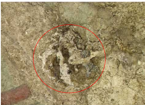
漆喰の粗鬆化により陥没した例 (西壁女子群像) (左) および充填箇所 (右)
