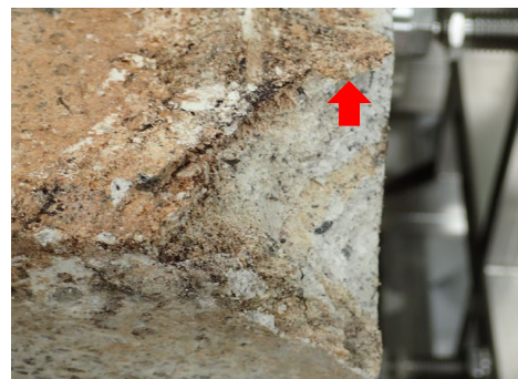
写真4 状態確認箇所 東男子 充填補強
