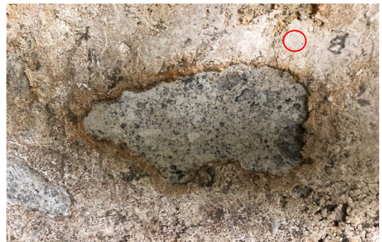
写真2 状態確認箇所 天井3 解体時 MC 噴霧
