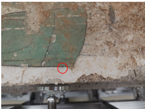
状態確認箇所 東男子 解体時
