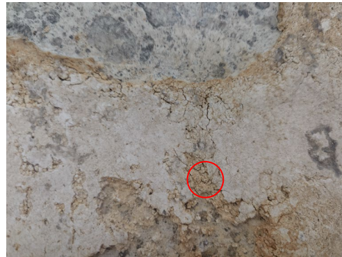
状態確認箇所 天井3 解体時 MC 噴霧
