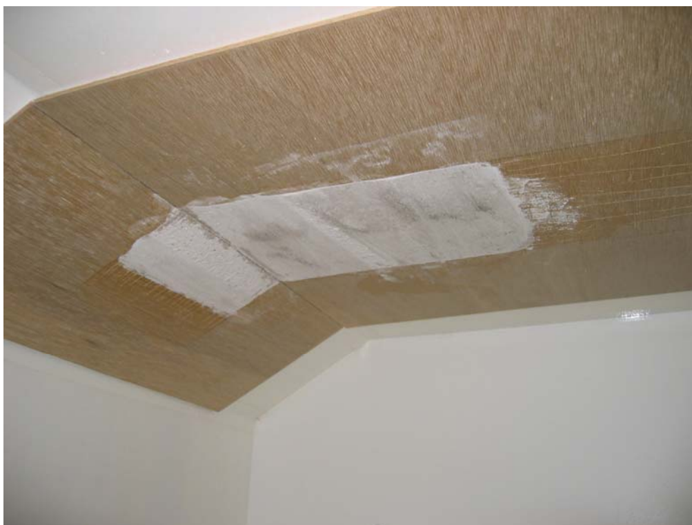
バンドソー実験：漆喰取り外し後壁面
