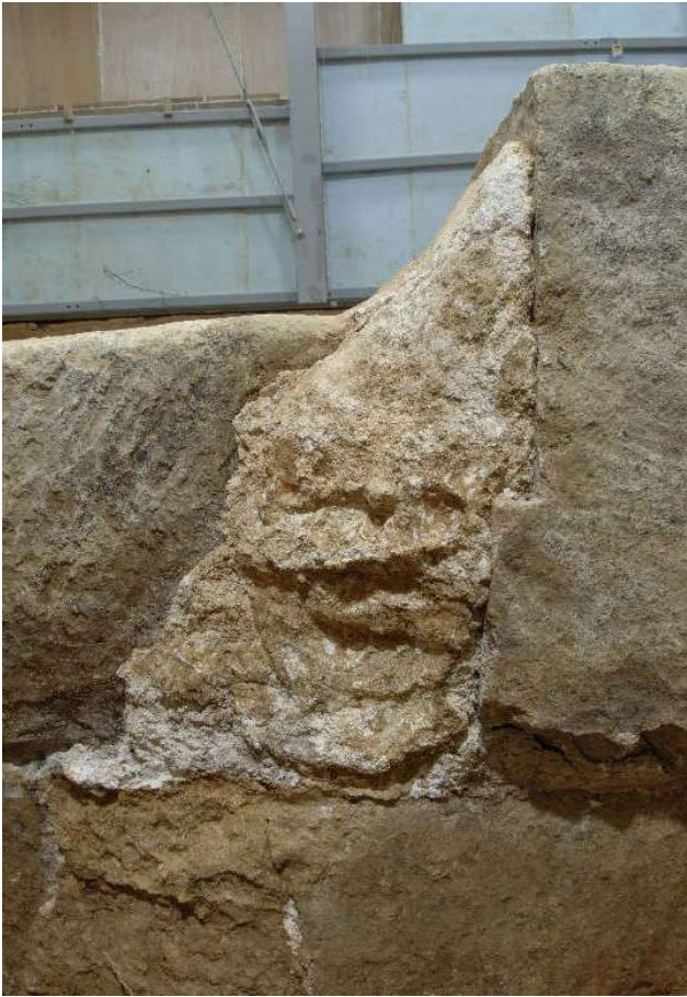
1 天井石3・4接合部西側面の漆喰
