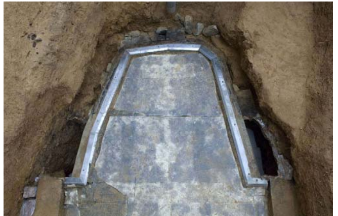
6 ふさぎ用PC版除去後の状況
