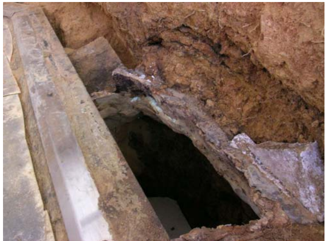
8 取合部東側の天井部分
