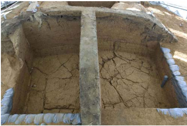
1 下部版築層の亀裂
