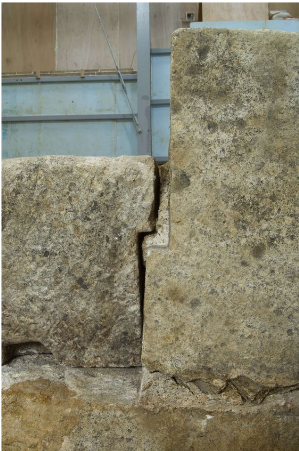
3 同上西側面漆喰除去後の状況
