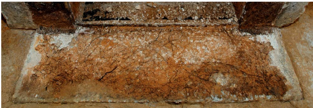
5 床石4上面（北壁石下）のカビと根
