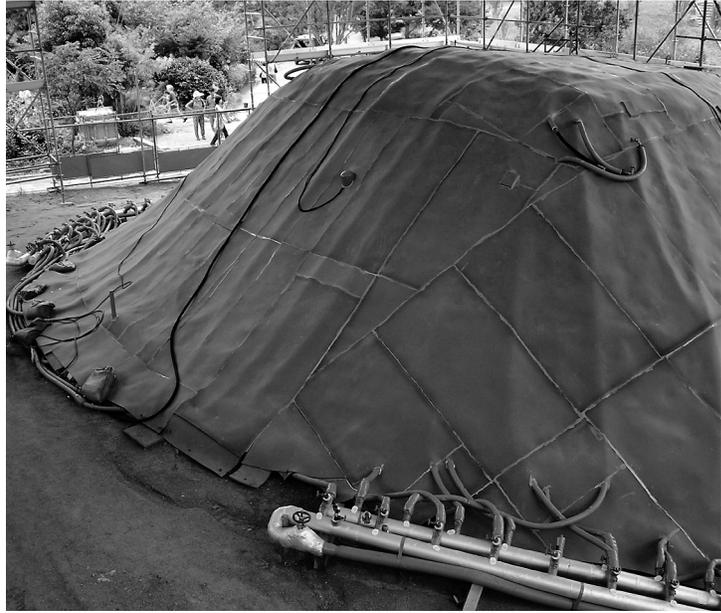
冷却管、断熱シートの設置状況
