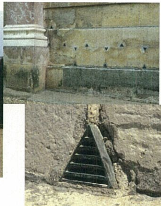
湿気抜きパイプの埋め込み
