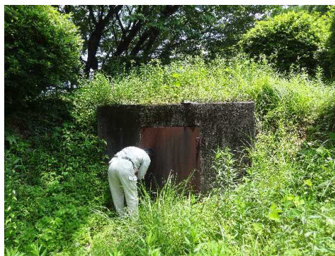
古墳石室保護施設
