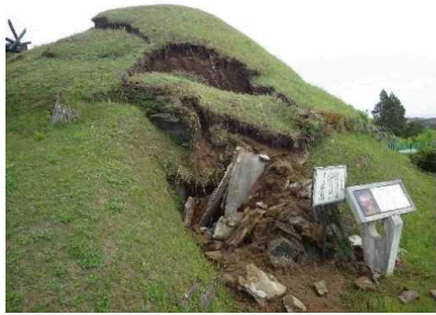
墳丘の崩落状況
