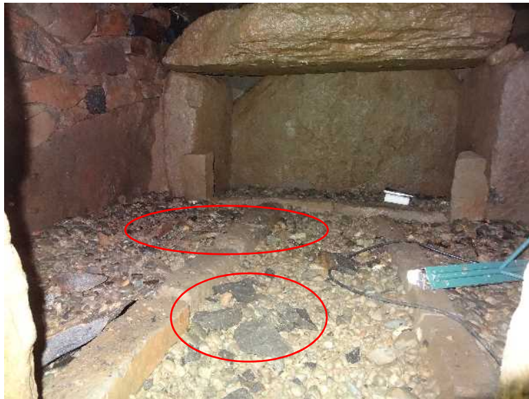
玄室天井石 剥落落下状況(左 照明台転倒)
