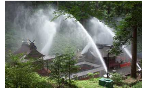
≪消火設備(放水銃)の設置≫
