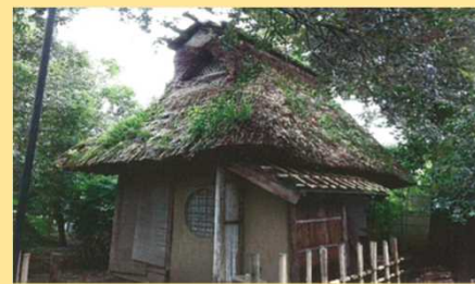
(名勝庭園の美観向上 (屋根の部分葺き替え))
