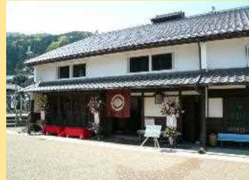
(伝統的な家屋の宿泊施設への転用)
