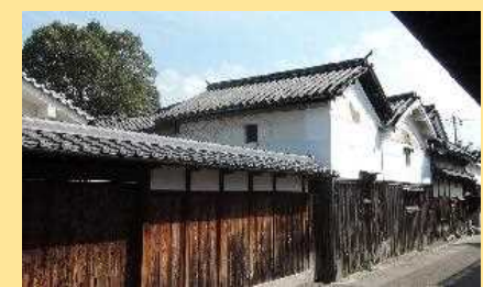
(伝建地区の美観向上 (外壁漆喰の塗りなおし))
