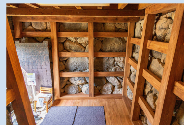
安全対策・附櫓内部穴蔵の木格子
