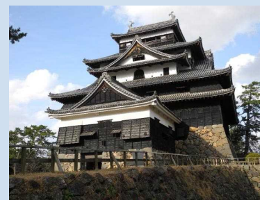
松江城天守外観
