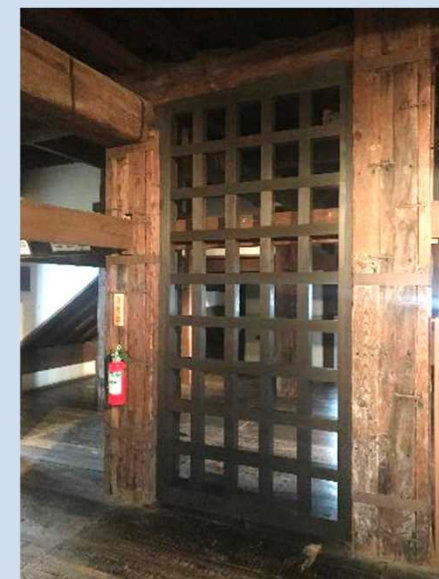
耐震補強・三階の木製格子壁
