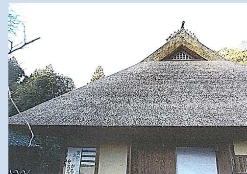
修理後（南から）
