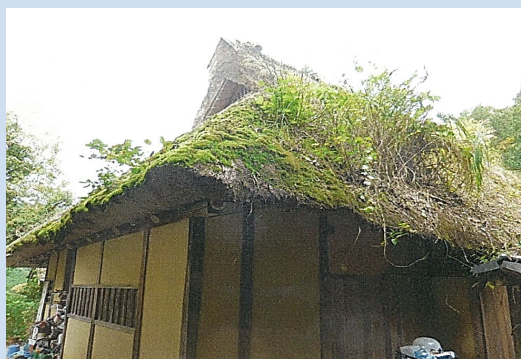
修理前（南東から）
