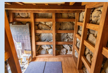
安全対策・附櫓内部穴蔵の木格子
