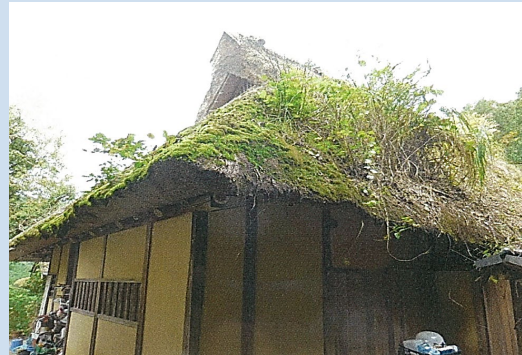
修理前（南東から）
