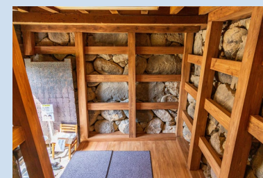
安全対策・附櫓内部穴蔵の木格子
