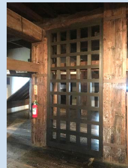
耐震補強・三階の木製格子壁
