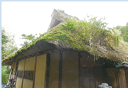
修理前（南東から）
