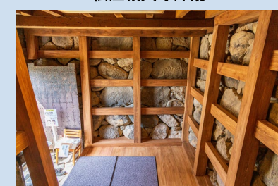
安全対策・附櫓内部穴蔵の木格子
