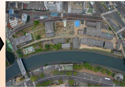
整備後(平成26年)
