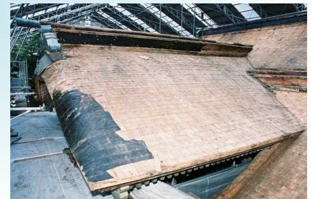
▲ 拝殿解体状況
