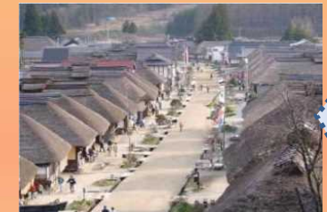
無電柱化(電柱移設)
