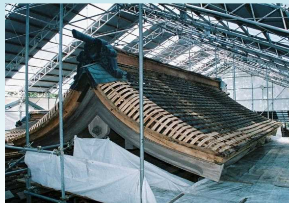
▲ 幣殿解体状況
