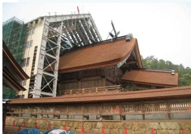
▲ 本殿 素屋根の解体
