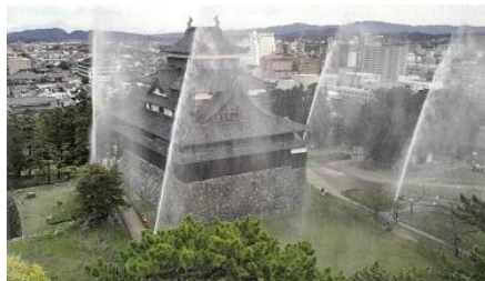
防災施設整備事業（放水銃等の整備）
