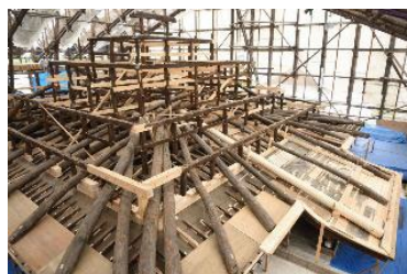
小屋組の修理状況
