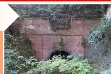
横浜水道 川尻隧道下口
