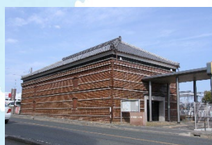
旧宮崎製糸鷺津工場繭倉庫
