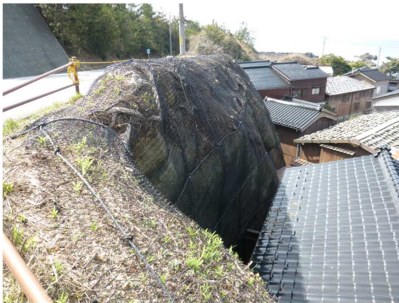
写真 30 斜面のネット補強 (佐渡市宿根木地区)
