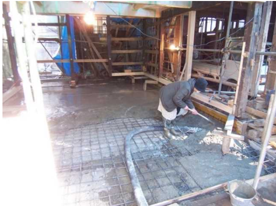
写真 29 べた基礎施工 (香取市佐原地区)
