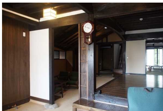
写真 16 土間に荒壁パネルによる補強壁を設置白色に仕上げ違和感ないようにした（鹿島市浜庄津町浜金屋町地区）
