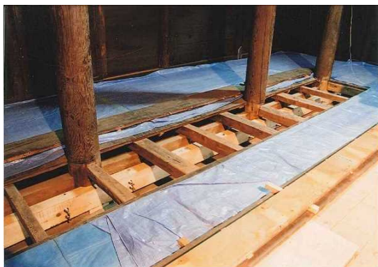
写真 31 柱足下の足固め補強 (永保寺観音堂)
