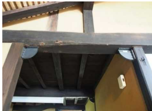
写真 21 開口部制振ダンパー
