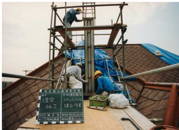
写真 25 煉瓦造煙突補強 鉄骨フレームの建込み （神戸市北野町山本通地区）
