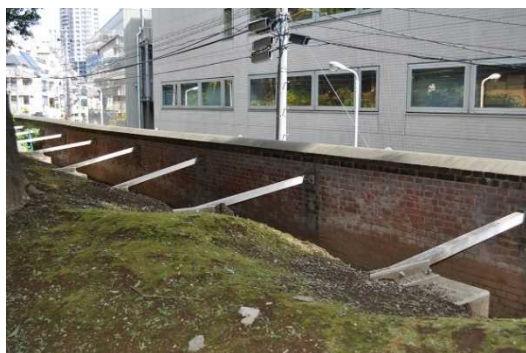
写真 37 煉瓦塀鉄骨補強（旧岩崎家住宅）
