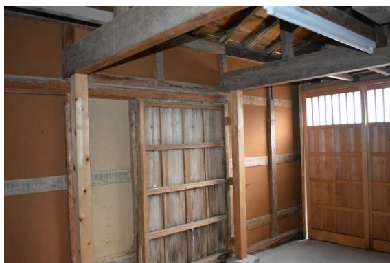
写真 32 梁下に設けられた付柱 (旧角海家住宅敷地内建物)
