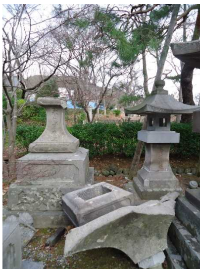
写真 38 石灯籠の地震被害状況
