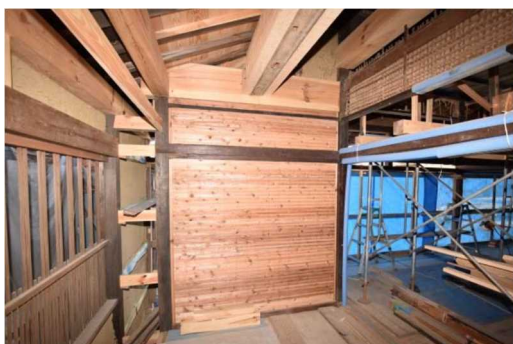
写真 17 耐震小舞補強 写真は下地でこの後左官仕上げを実施（大田市大森銀山地区）
