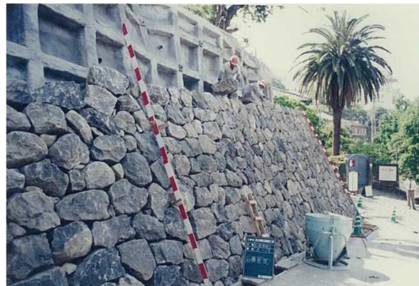
写真 43 擁壁にラス張りを施工し、法枠工、アンカー工で補強し練積で復旧した石垣（長崎市東山手地区）
