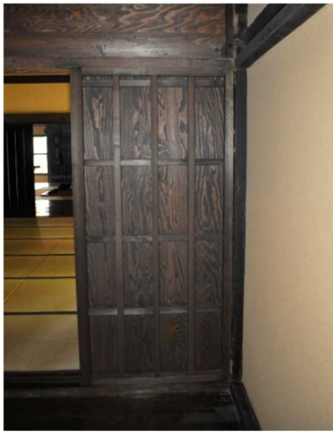
写真 19 板戸形合板耐震壁
