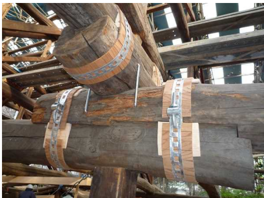
写真 33 梁継手バンド補強 (護国寺月光殿)
