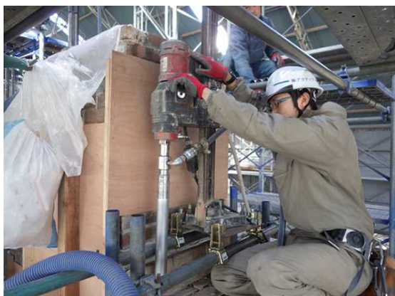
写真 24 煉瓦造煙突補強 引張材挿入のための削孔 （神戸市北野町山本通地区）
