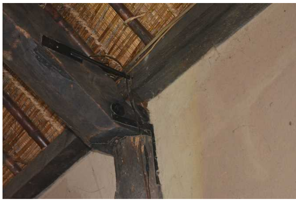
写真 34 柱梁接合部金物補強 (旧中澤家住宅)
