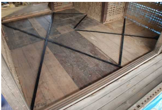
写真 22 床面畳下鋼製平板ブレース補強
