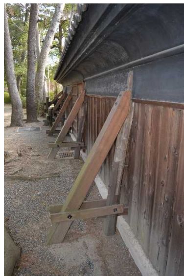
写真 36 塀へ控柱追加及び基礎補強 （六華苑敷地内塀）
