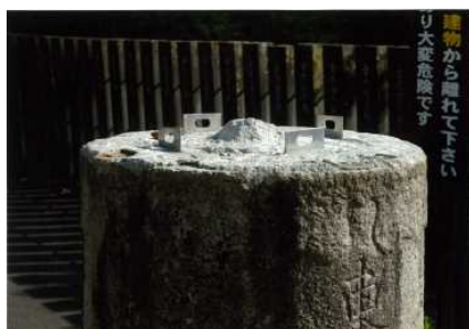
写真 40 ステンレス板によるずれ止
