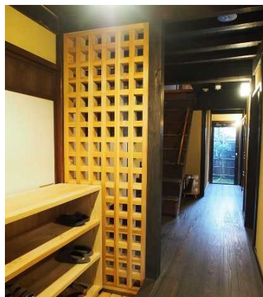
写真 14 格子壁補強（素木のまま）（金澤町家情報館）
