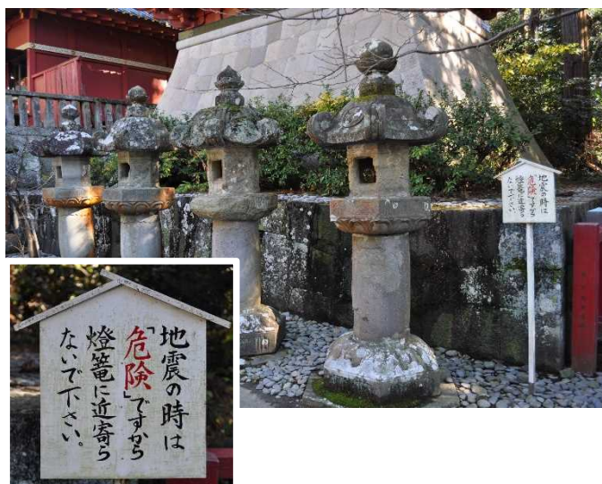
写真 39 石灯籠の危険性明示看板
