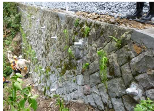
写真 44 セメント系注入材を裏栗石に注入し固化させる工法を用いた石垣補強事例
