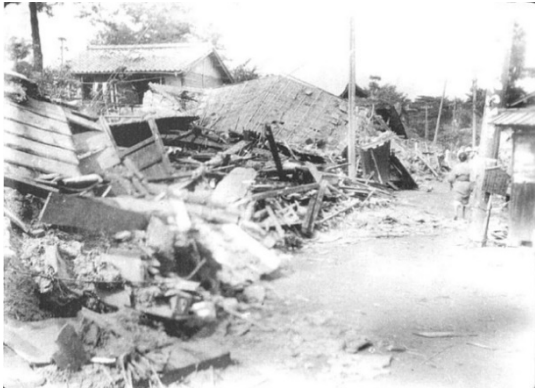
写真 7 家屋倒壊により狭くなった道路
