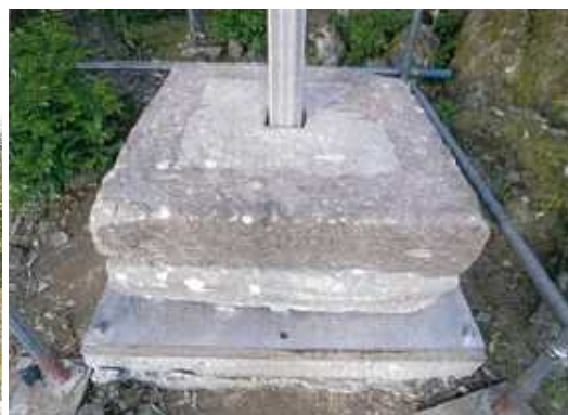
写真 41 石塔内部ステンレス柱による補強 (重要文化財十三重塔)
