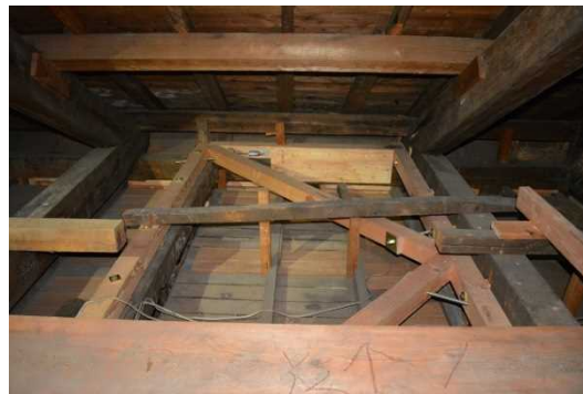
写真 23 水平構面補強 小屋裏木製筋違補強
