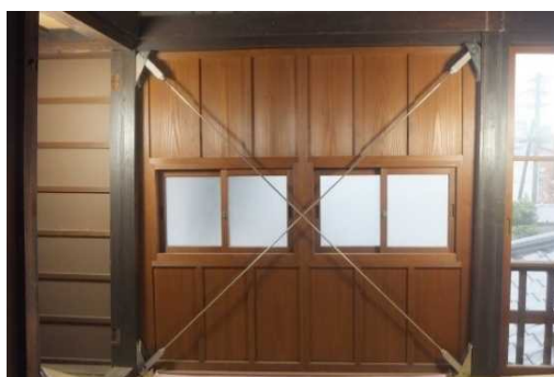
写真 18 鋼棒ブレース補強（鹿島市浜中町八本木宿地区）
