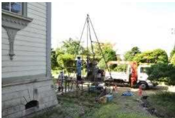
写真 45 ボーリングによる地盤調査（実調査）
