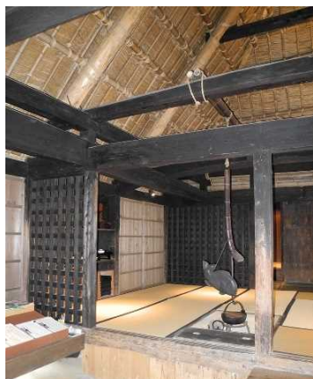
写真 13 格子壁補強（黒色塗装）（旧増田家住宅）
