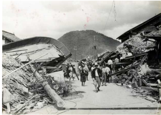
写真 8 家屋倒壊により狭くなった道路
