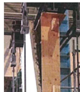
図12 土壁剥離 (⑥)
