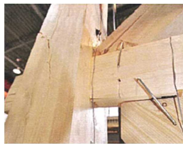
図8 柱の曲げ破断 (③)
