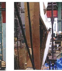
図16 土壁剥離 (⑧)
